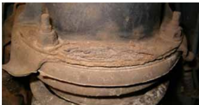
Foto 2: Schokdemperbevestiging aangestast door roest.
